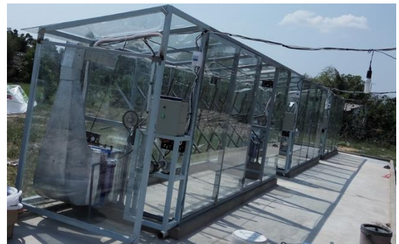
Hình 4. Hệ thống thực tế đã được lắp đặt tại huyện Củ Chi
